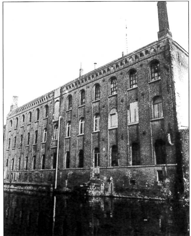
Gent stoombroodbakkerij Volksbelang, Waaistraat. Imponerend fabrieksgebouw met rondboogige ramen (achtergevel uitgevend op de Leie) geb. als rijstpelderij in 1857, op de plaats van een suikerraffinaderij. Van 1873 tot '79 gebruikt als stoomkatoonspinnerij. Straatzijde thans tot garage omgevormd. Mechanisme (stoom)broodbakkerij door de N.V. "Volksbelang" opgericht.
